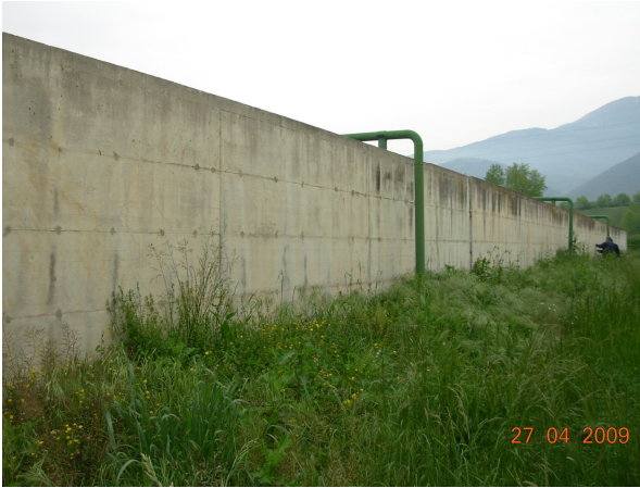
Foto 13 – Impianto di Corfinio. Vasca di areazione. Parete longitudinale
