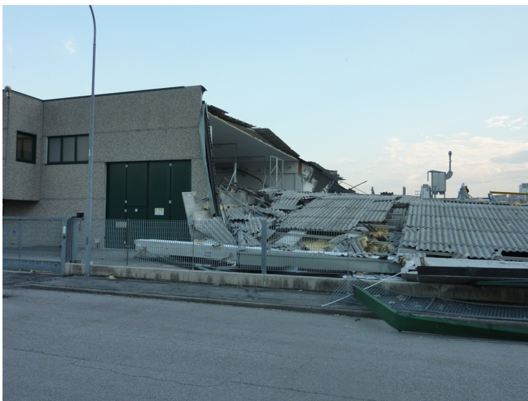
23 Maggio 2012 - S. Agostino – Capannone n. 4.
