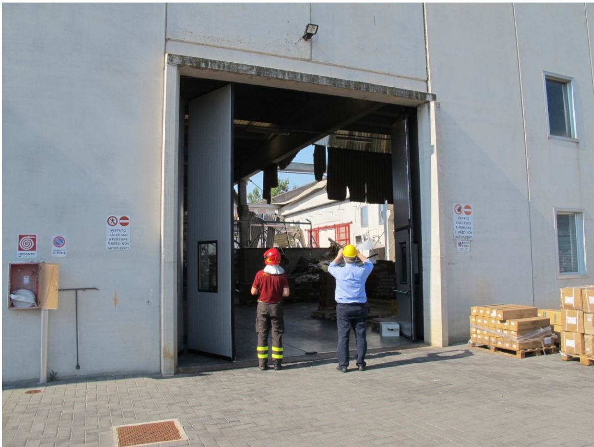
29 Maggio 2012 (dopo 2° sequenza) - S.GR Mirandola (Aries biomedicale) – Capannone n. 9 (fronte).
