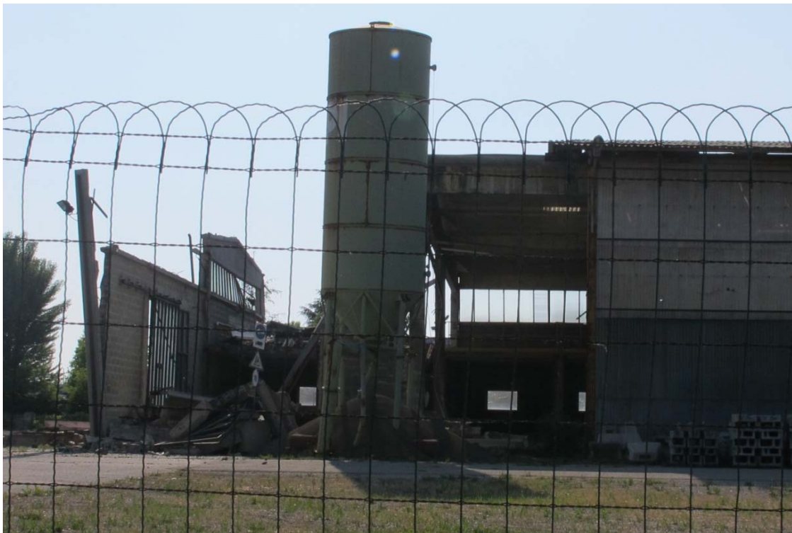
29 Maggio 2012 (dopo 2° sequenza) - S.GR Mirandola – Capannone n. 13.
