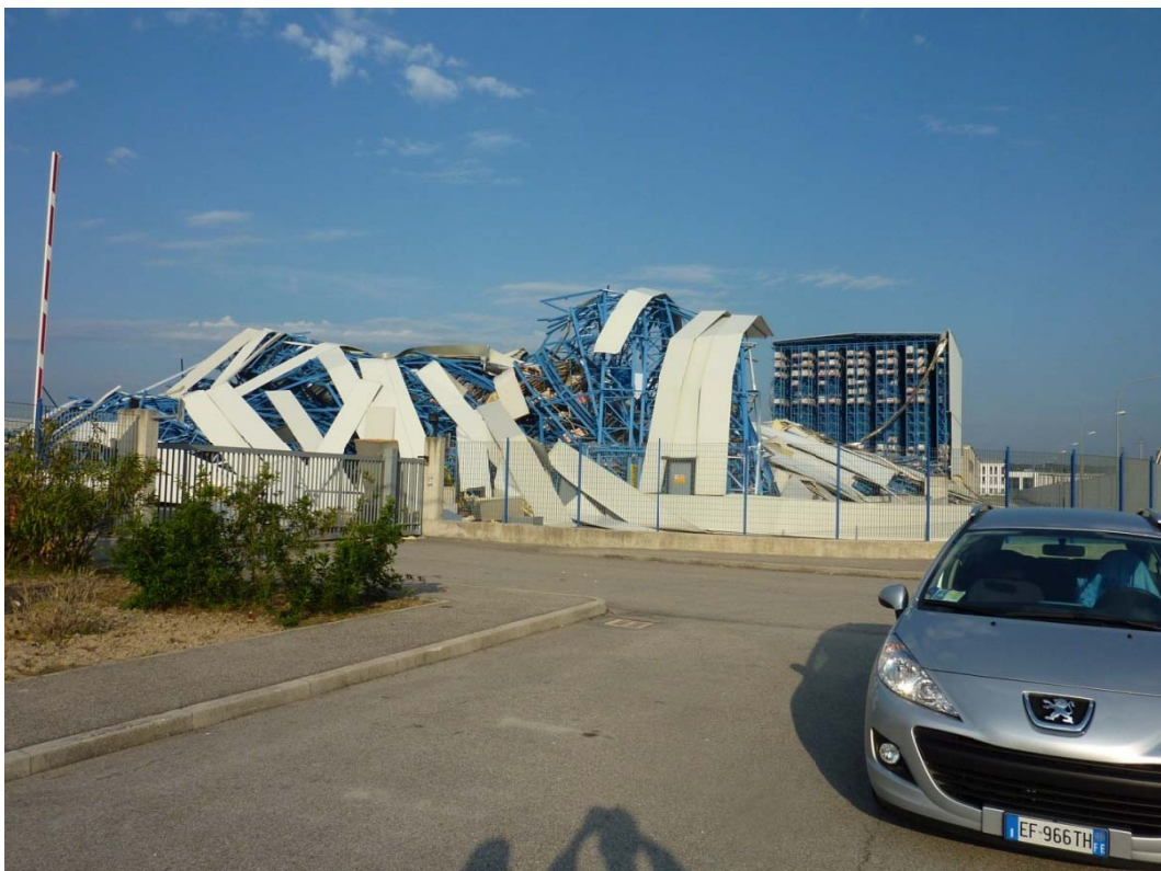
23 Maggio 2012 - S. Agostino – Capannone n. 1 (Ceramiche S. Agostino) – collasso di magazzino automatizzato.
