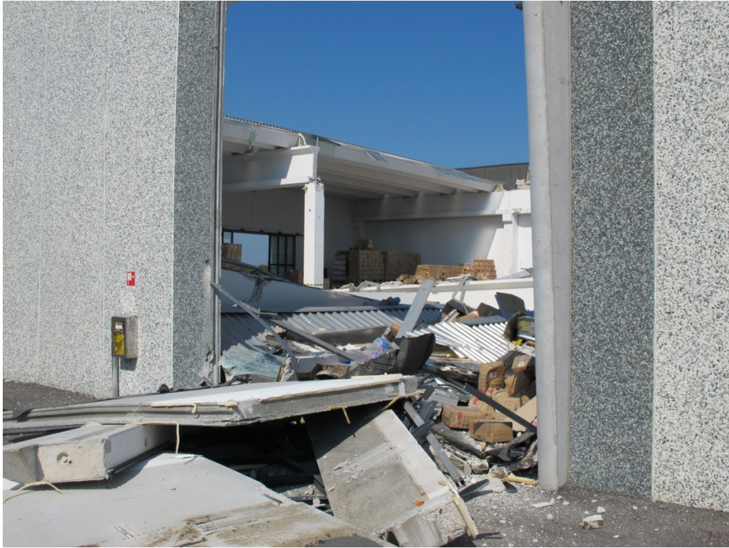
29 Maggio 2012 (dopo 2° sequenza) - Mirandola Nord – Capannone n. 6 – collasso interno con cedimento pilastri interni.
