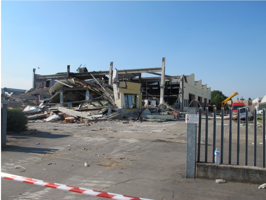
29 Maggio 2012 (dopo 2° sequenza) - S.GR Mirandola (BBG) – Capannone n. 10.
