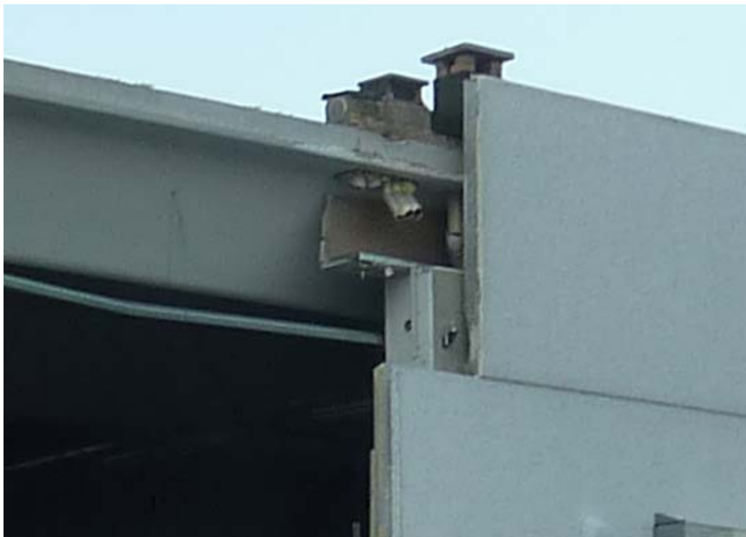
23 Maggio 2012 - S. Agostino – Capannone n. 3 – particolare dell'aggancio della tamponatura.
