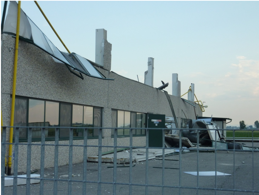
23 Maggio 2012 - S. Agostino – Capannone n. 4 - facciata retrostante.
