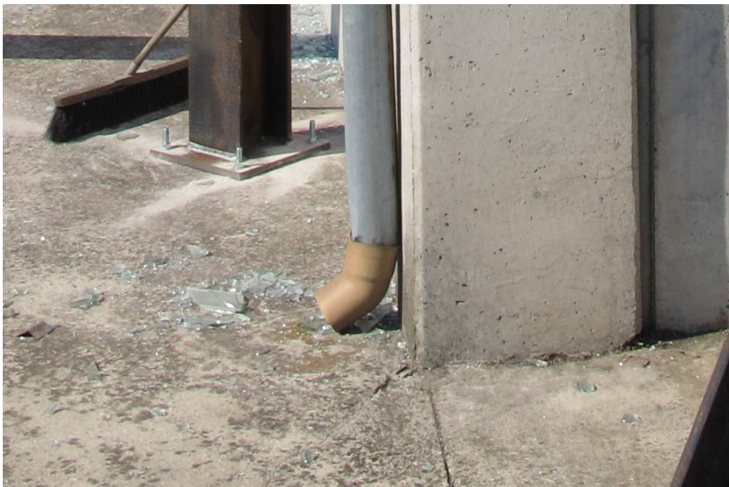
28 Maggio 2012 - S.GR Mirandola – Capannone n. 4 attività biomedicale – messa in sicurezza di trave sfilata dal pilastro che ha subito una rotazione alla base.
