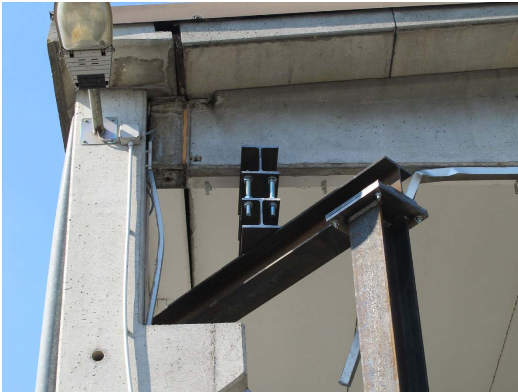
28 Maggio 2012 - S.GR Mirandola – Capannone n. 4 attività biomedicale – messa in sicurezza di trave sfilata dal pilastro che ha subito una rotazione alla base.
