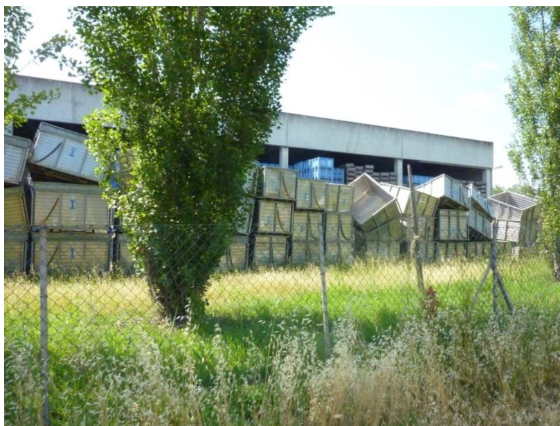
23 Maggio 2012 - La zona industriale di S. Felice sul Panaro.
