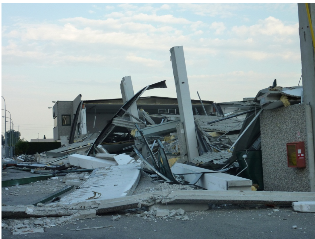
23 Maggio 2012 - S. Agostino – Capannone n. 4.
