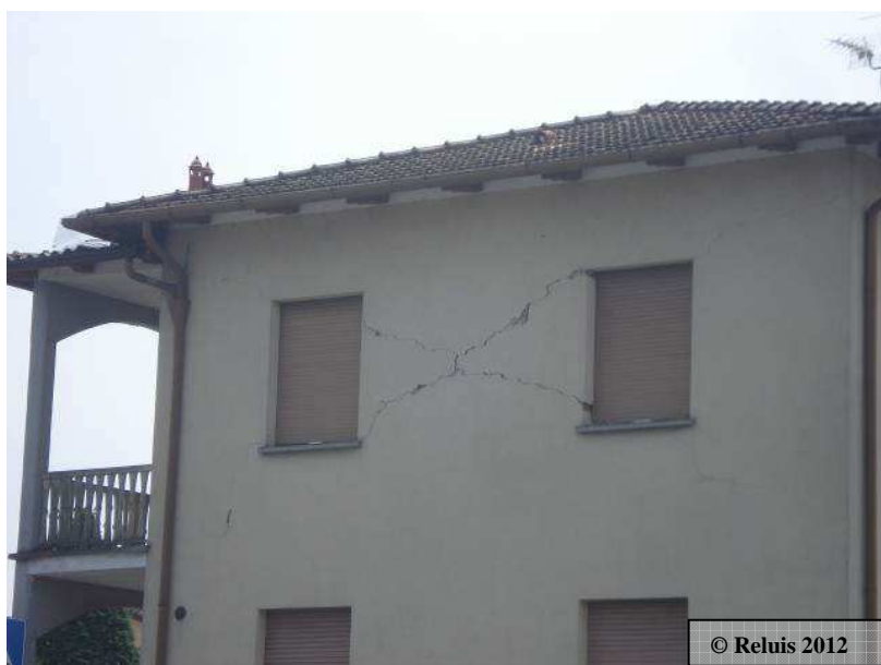
Figura 1- Pieve di Cento: lesioni a taglio di una parete in mattoni
