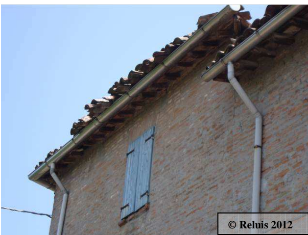
Figura 6 – Camposanto: crollo di tegole in un edificio in muratura
