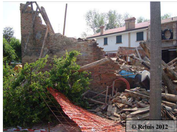
Figura 9 – Medolla: collasso di una struttura in muratura
