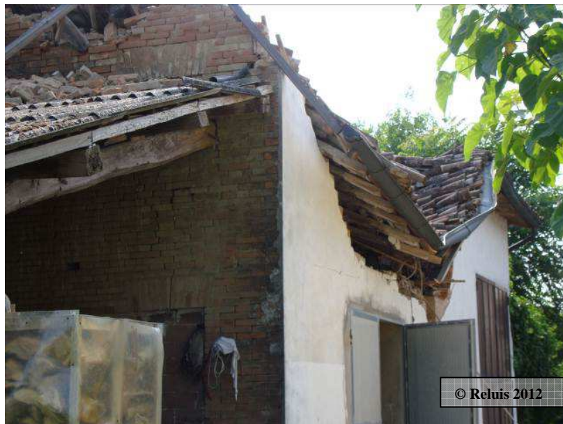
Figura 12 – Medolla: ribaltamento fuori dal piano parete e conseguente perdita di appoggio della copertura
