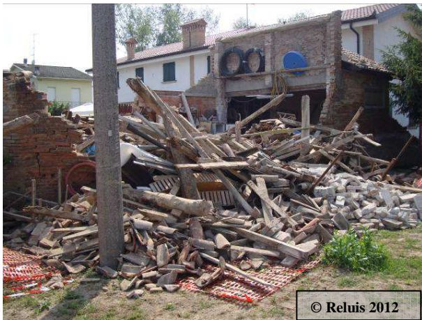
Figura 9 – Medolla: collasso di una struttura in muratura
