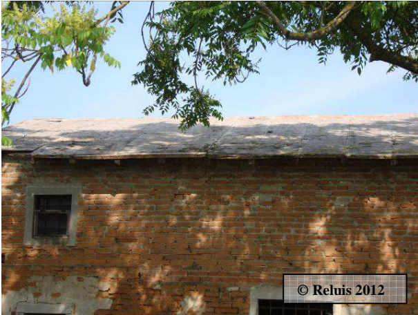
Figura 11 – Medolla: Crollo delle tegole in un edificio in muratura
