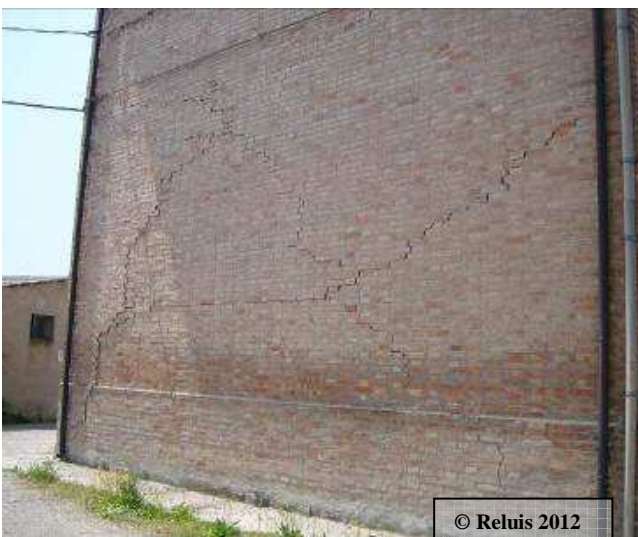
Figura 4 – Camposanto: lesioni a taglio in un edificio in muratura
