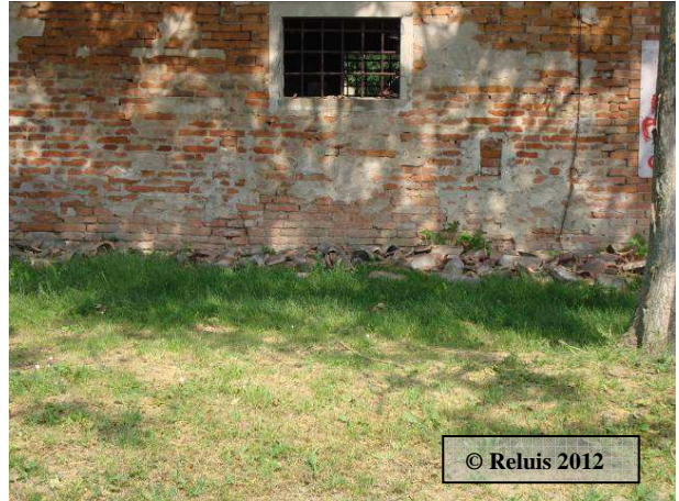
Figura 11 – Medolla: Crollo delle tegole in un edificio in muratura
