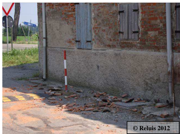
Figura 6 – Camposanto: crollo di tegole in un edificio in muratura
