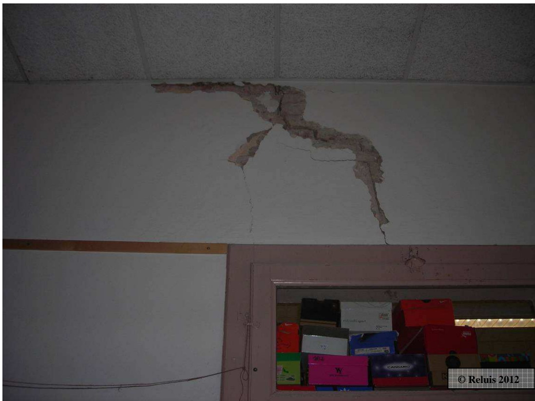
Figura 16 – Pieve di Cento: Scuola De Amicis: Tipiche in corrispondenza degli architravi di vani
