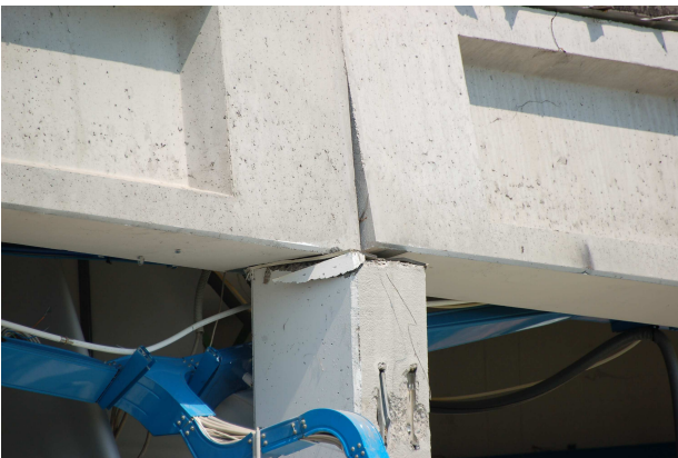
Figura 20 – Crollo di pannelli di tamponatura orizzontali in un edificio monopiano prefabbricato
