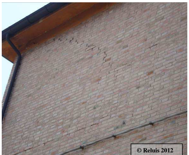
Figura 4 – Camposanto: lesioni a taglio in un edificio in muratura
