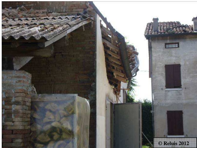
Figura 11 – Medolla: Crollo delle tegole in un edificio in muratura
