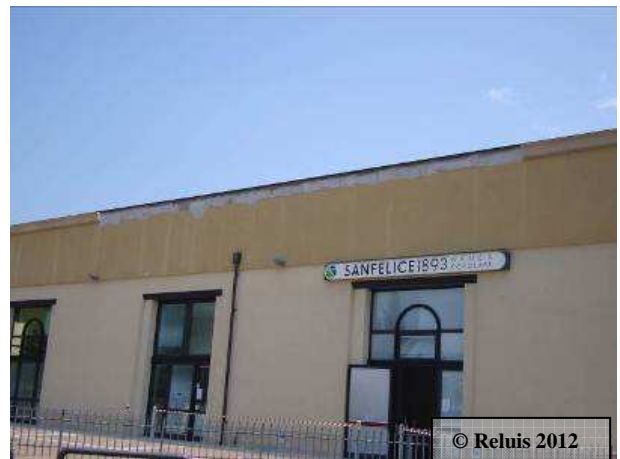
Figura 3 – Camposanto: crollo di un cornicione
