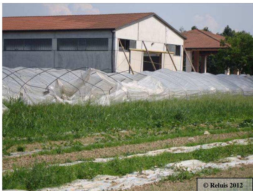
Figura 10 – Medolla: puntellatura di pannelli di tamponatura prefabbricati a causa dell'incipiente collasso
