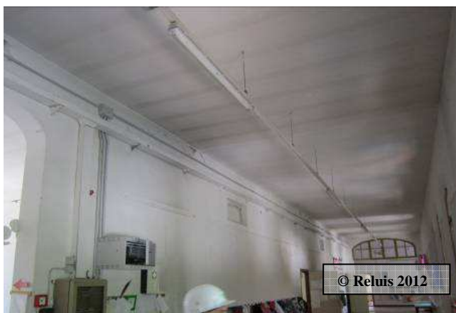
Figura 35 - Inneschi di distacco parete solaio.
