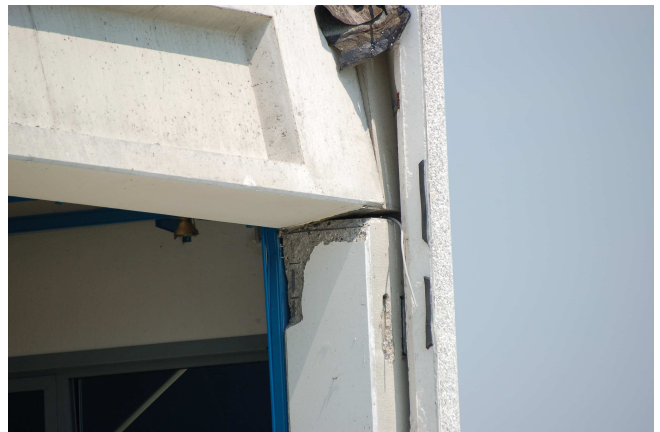
Figura 20 – Crollo di pannelli di tamponatura orizzontali in un edificio monopiano prefabbricato
