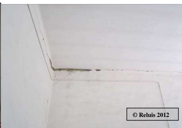
Figura 35 - Inneschi di distacco parete solaio.
