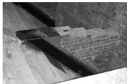
Figure 15. Palazzo Ducale di Urbino: reinforced transverse vertical diaphragms.
