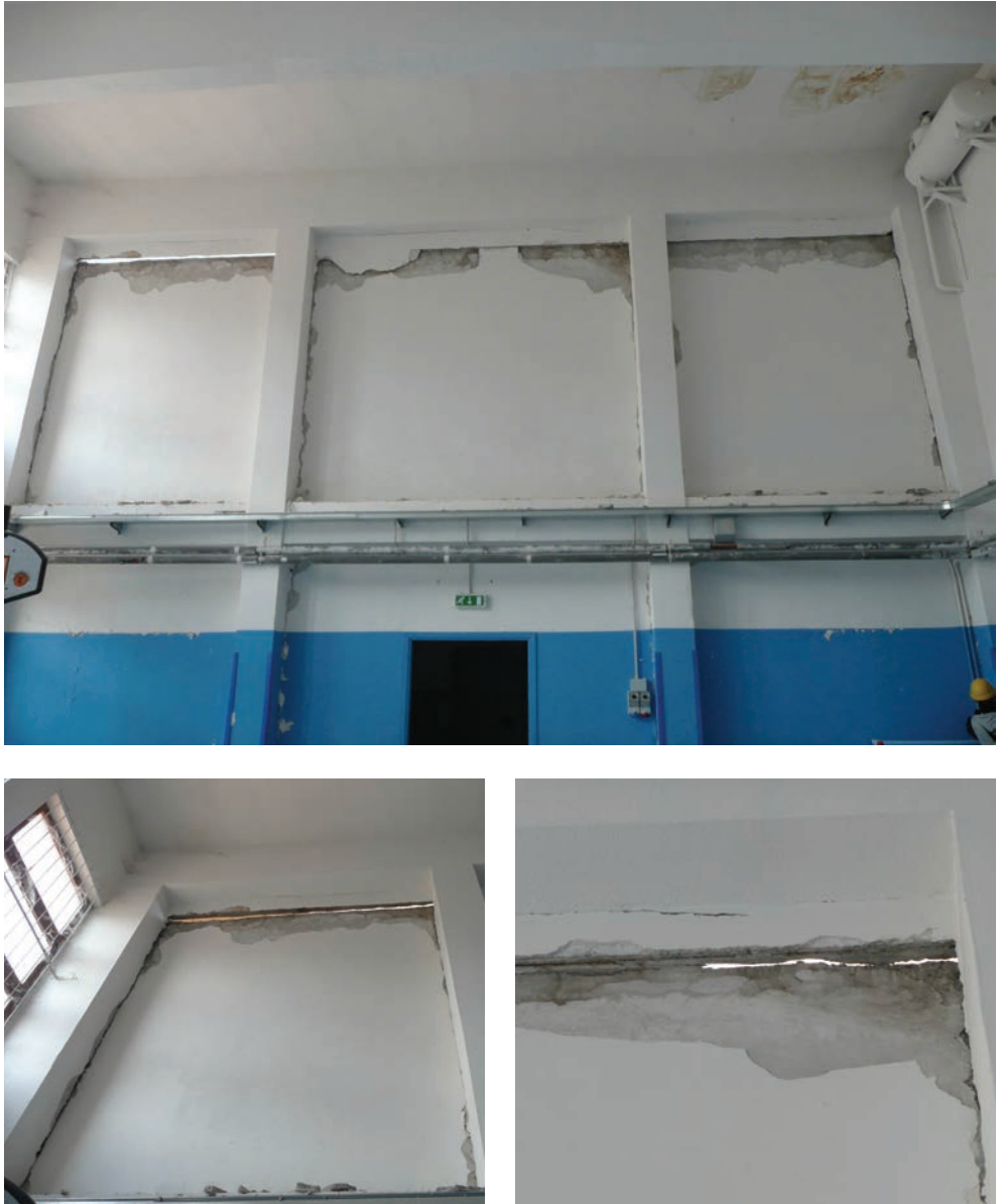
Figura 2.11. Incipiente ribaltamento verso l'esterno della tamponatura: vista d'insieme (in alto); viste di dettaglio (in basso) (foto: G. Della Corte, B. Faggiano).
