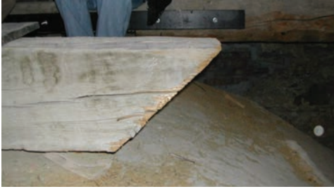
Figura 3.168. Ricostruzione dell'estremità di trave in legno appoggiata alla parete muraria mediante protesi di testata.
