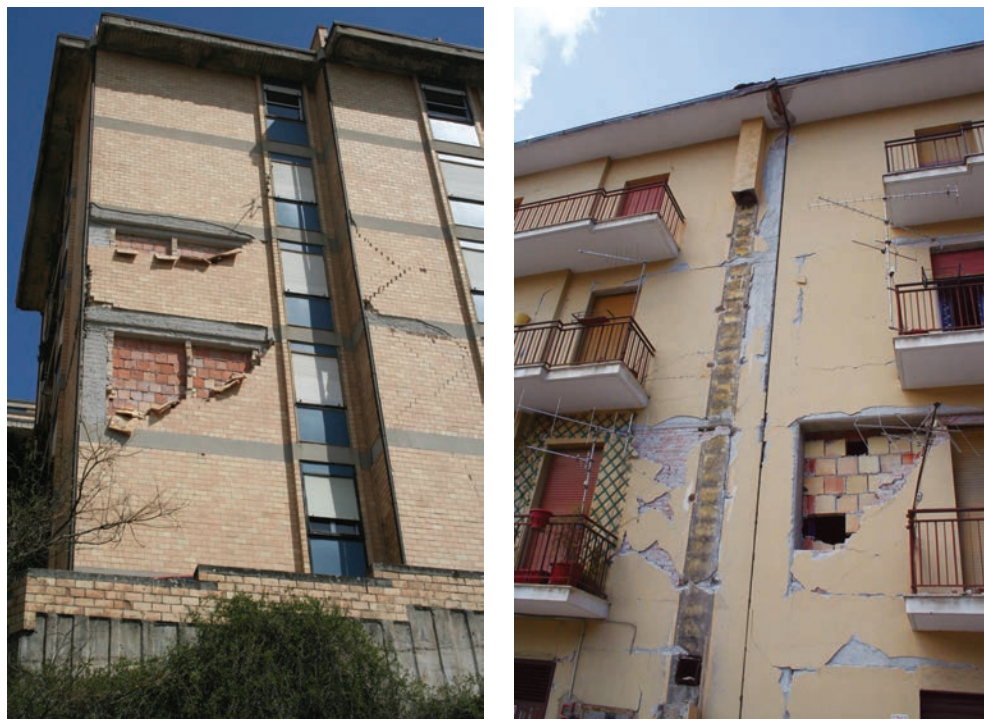
Figura 2.14. Crolli parziale della fodera esterna: due viste d'insieme (foto: I. Iervolino, A. Prota, P. Ricci, G.M. Verderame).
