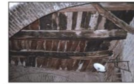
Solaio in legno con tavolata a semplice orditura.
