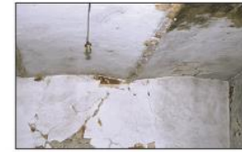
Solaio con travi di ferro e voltine.
