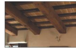
Solaio in legno con mezzane
