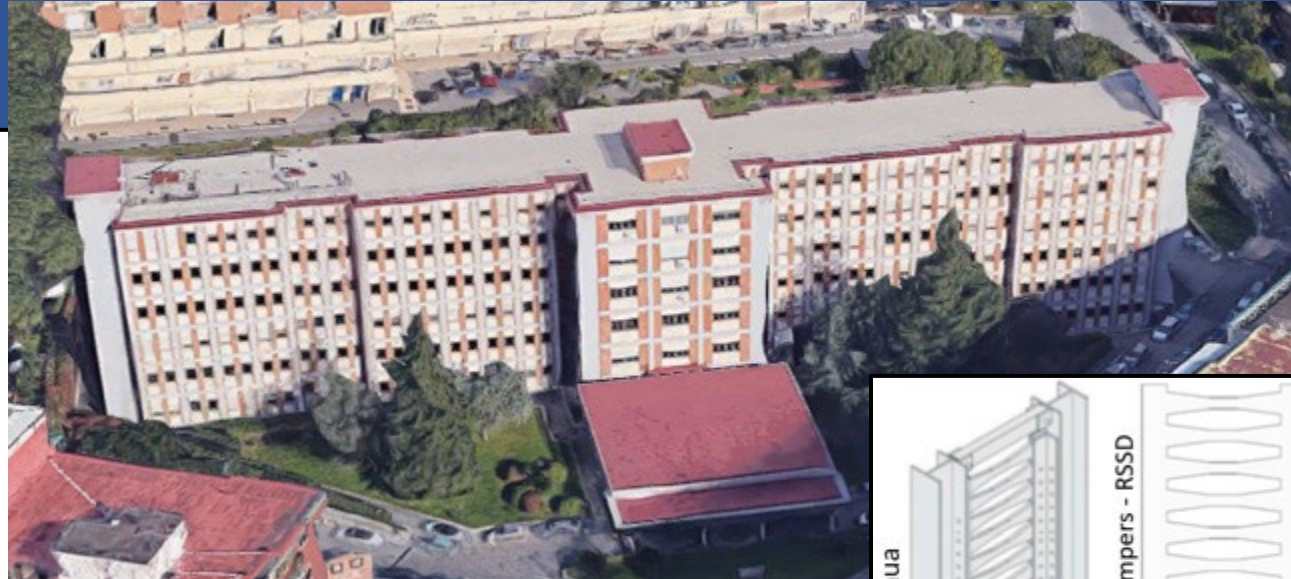
Edificio a struttura mista acciaio-calcestruzzo
