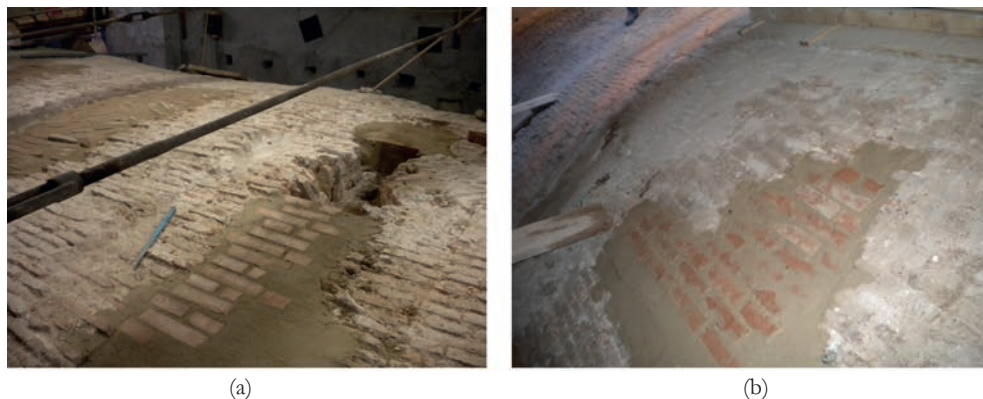
Figura 5.8. Intervento di riparazione di volte in mattoni con inserimento di nuovi elementi.
