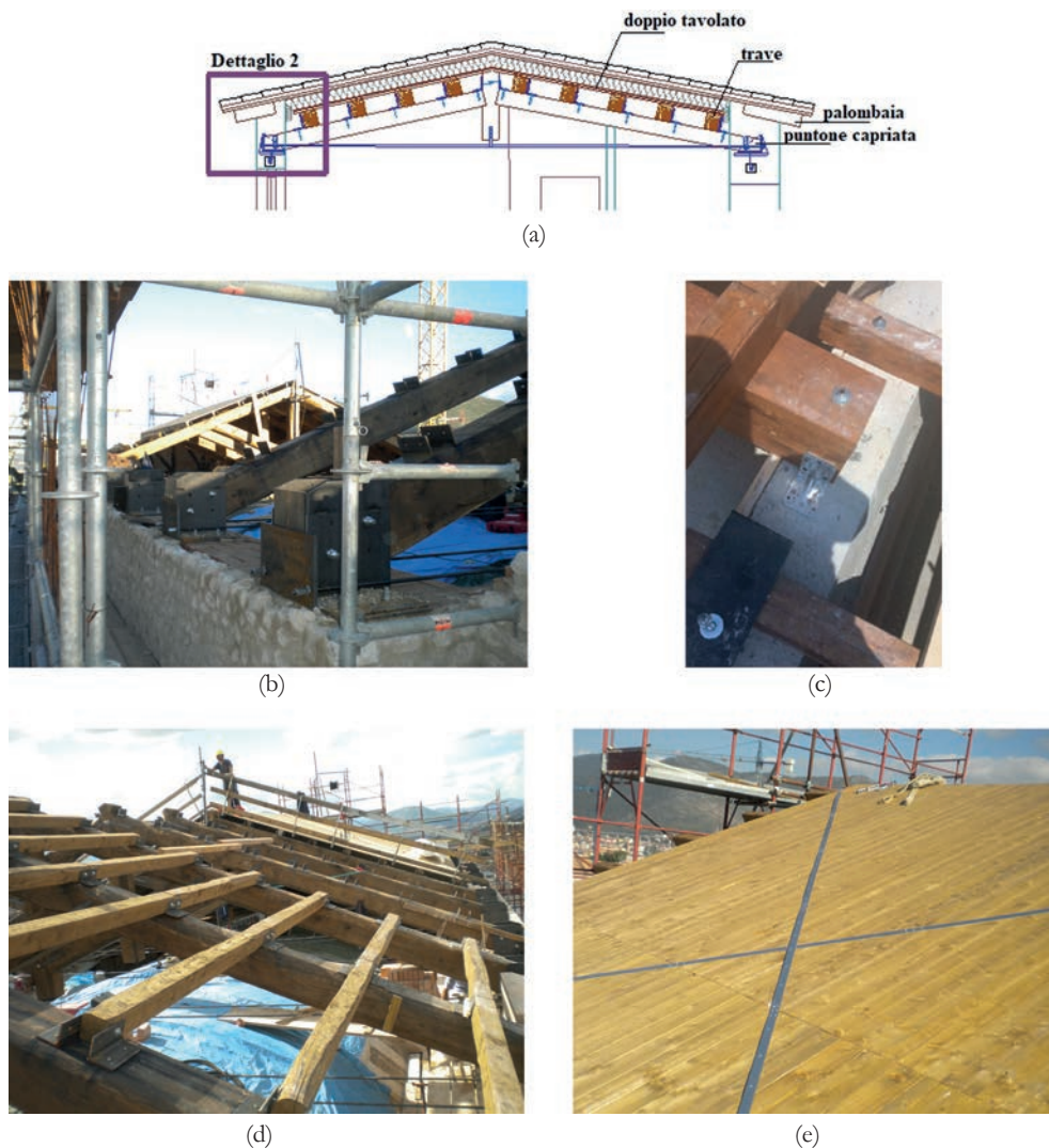
Figura 5.14. Intervento di ricostruzione di una copertura in legno: a) un particolare costruttivo; b), c) dettagli degli ancoraggi degli elementi in legno ai cordoli; d), e) fasi di montaggio della copertura.
