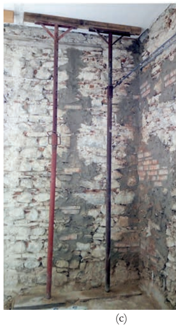
Figura 5.2. Particolare sarcitura di lesioni (a), particolare costruttivo della chiusura di vuoti nelle murature (b) e relative foto degli interventi su strutture esistenti (c), (d).
