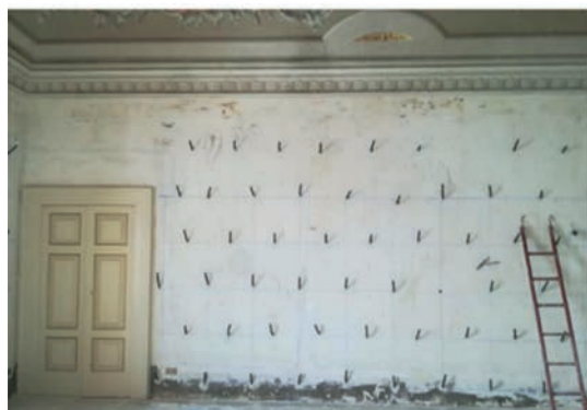
Figura 5.5. Consolidamento dei pareti murarie con iniezioni di malta: a) particolare costruttivo; b) foto con beccucci per le iniezioni; c) foto durante la fase di iniezione della malta.
