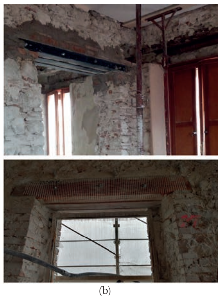
Figura 5.3. Interventi su architravi: a), particolare costruttivo; b) foto di un nuovo architrave in acciaio (sopra) e in legno (sotto).
