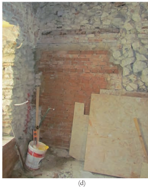
Figura 5.2. Particolare sarcitura di lesioni (a), particolare costruttivo della chiusura di vuoti nelle murature (b) e relative foto degli interventi su strutture esistenti (c), (d).
