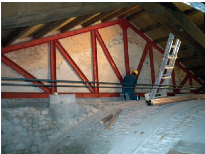
Figura 5.15. Realizzazione di una capriata in acciaio a sostegno di una copertura in legno.
