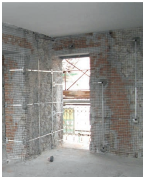
Figura 5.7. Consolidamento delle murature con sistema CAM.
