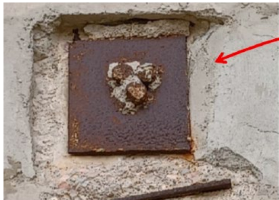
Difetti di iniezione e corrosione testate
