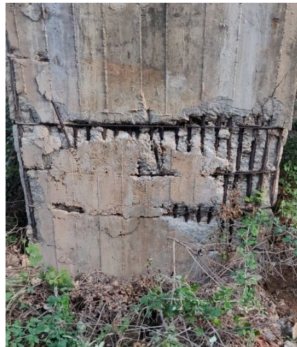
Degrado selle Gerber, spalling e corrosione armature pile e degrado sedi di appoggio
