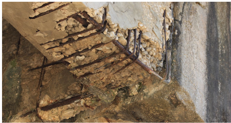
Degrado selle Gerber, spalling e corrosione armature pile e degrado sedi di appoggio
