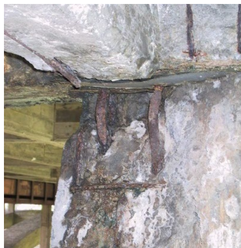
Degrado selle Gerber, spalling e corrosione armature pile e degrado sedi di appoggio
