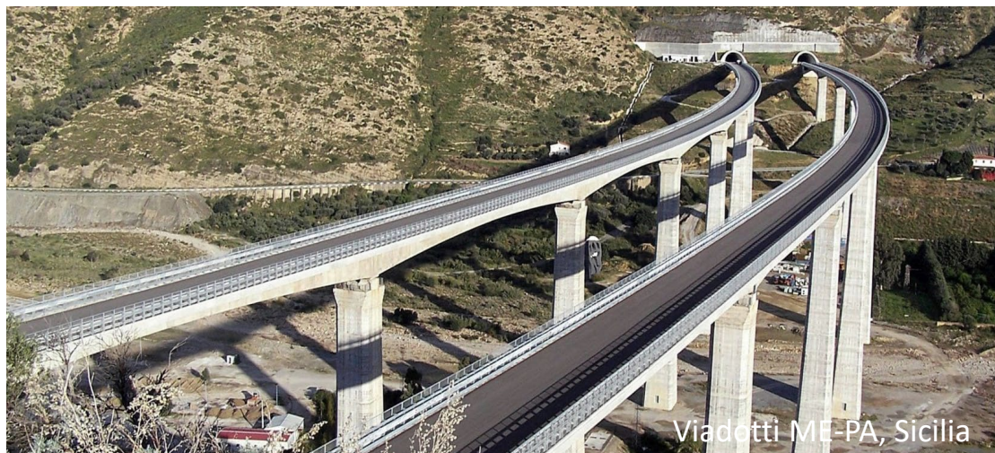
Trave continua in c.a.p. con sezione a cassone
