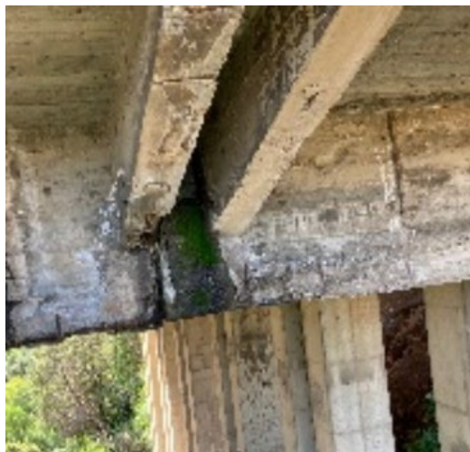
Degrado selle Gerber, spalling e corrosione armature pile e degrado sedi di appoggio
