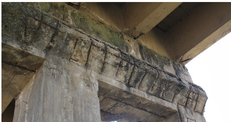
Corrosione armature pulvini e travi in c.a.
